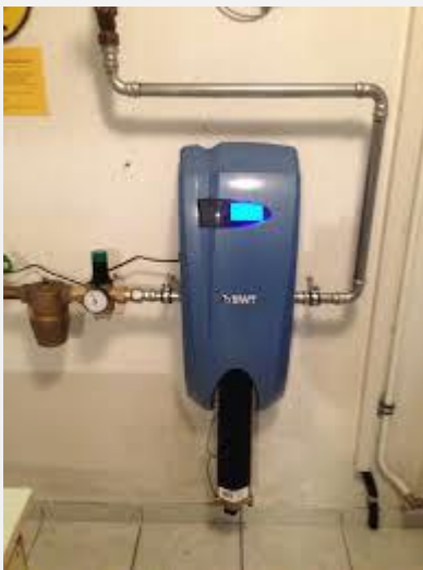
Afbeelding 11. De AQA TOTAL 1500 ENERGY van BTW is een kalkneutralisator waar gemiddeld jaarlijks een ander patroon wordt ingeladen zodat de werking continu verzekerd wordt.
