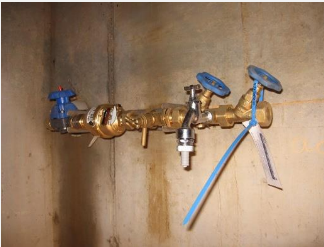
Foto 1. Een voorbeeld van een wateraansluiting uitgevoerd door de watermaatschappij
